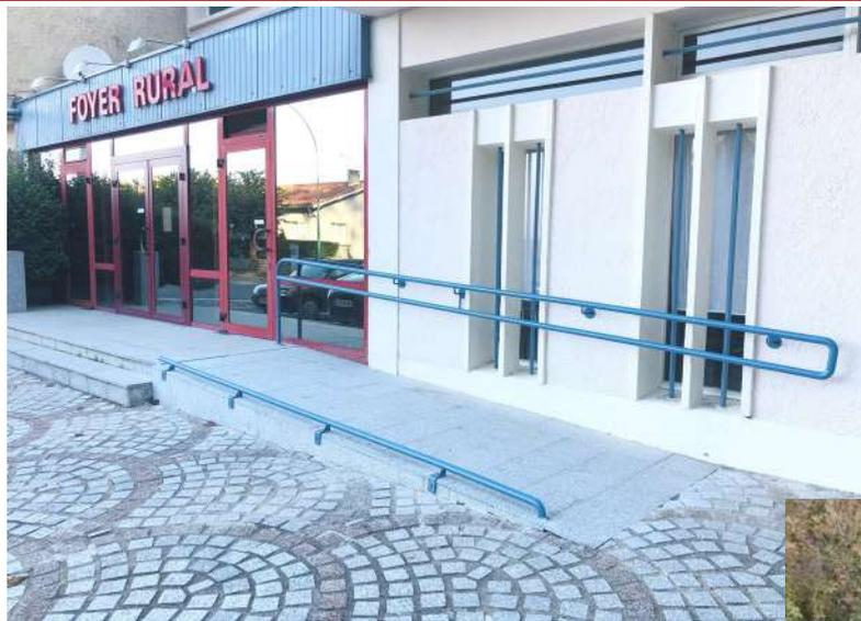
Mise en place au foyer d'une rampe d'accès normalisée pour faciliter et sécuriser l'accès aux personnes à mobilité réduite (chasse roue au sol et rampe à hauteur)
