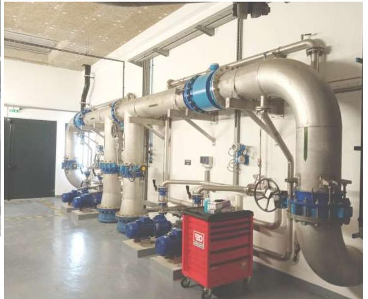
Station de pompage au pied du barrage de Rassisse avec 3 pompes de 500 KW.
